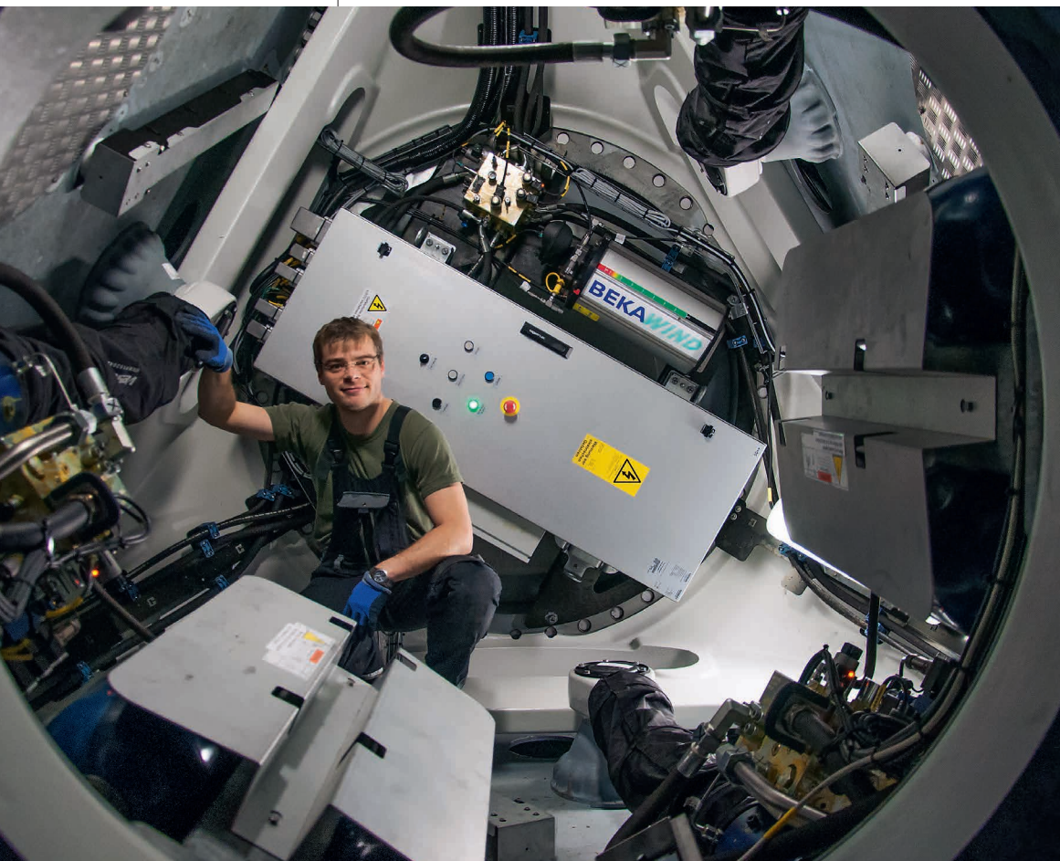
Was aussieht wie eine Raumkapsel, ist die Rotornabe der Vestas V126: Hier überprüft Marcus Drößler Hydraulikmotoren, mit denen die drei Windrad-Flügel verstellt werden können.
