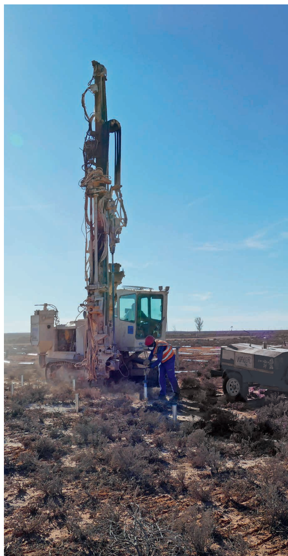
Untergestelle für exakt 275.760 Module werden mit dem entsprechenden Gerät im Boden verankert.
